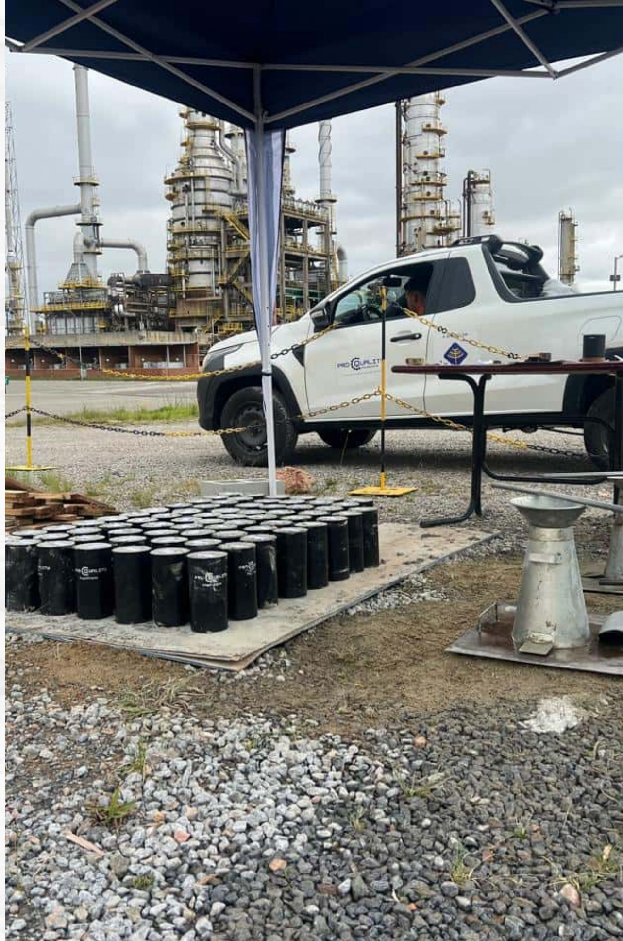
Slump Test e Moldagem de Corpos de Prova
